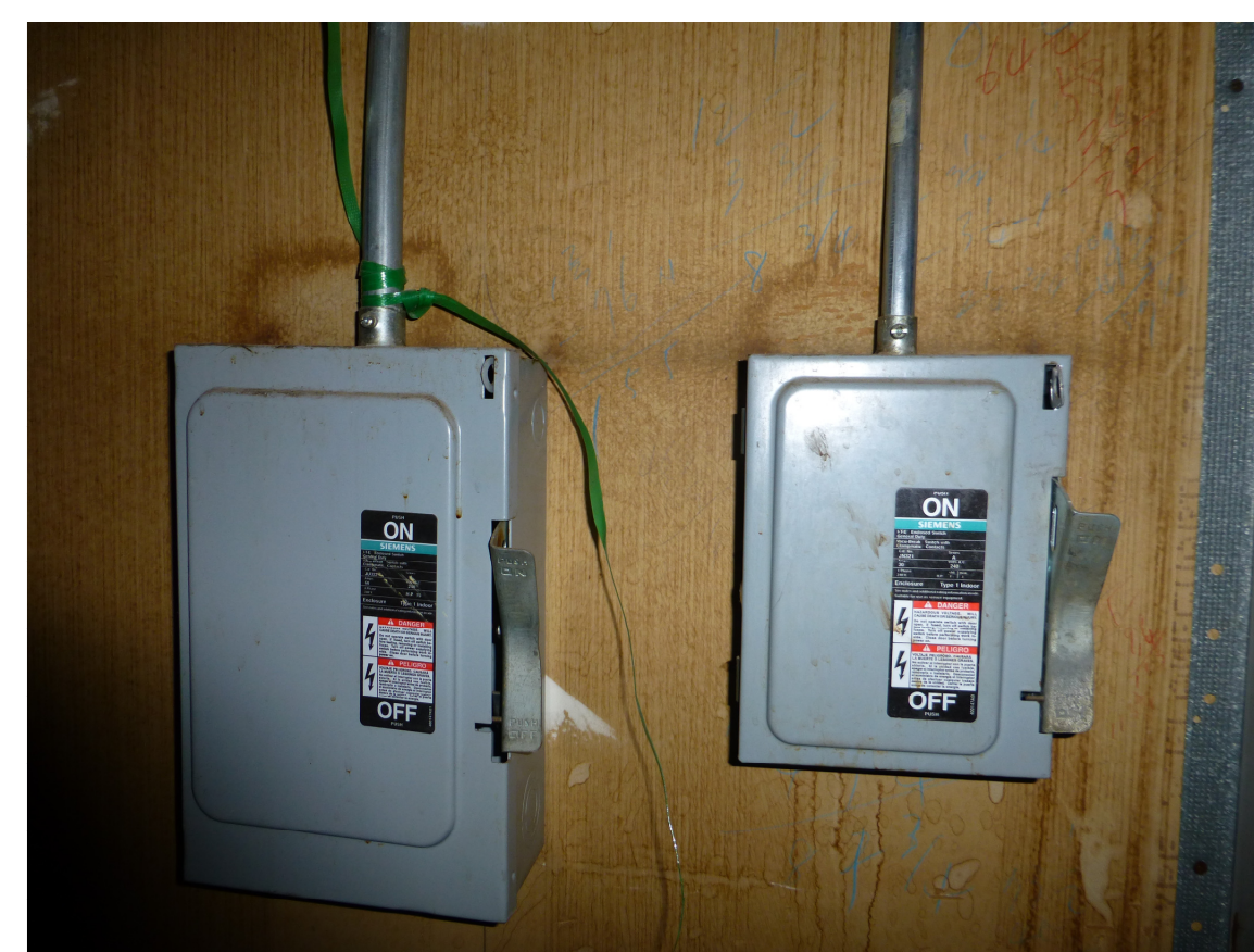
Disconnects 60 Amp/240 Volt & 30 Amp/240 Volt NTS
